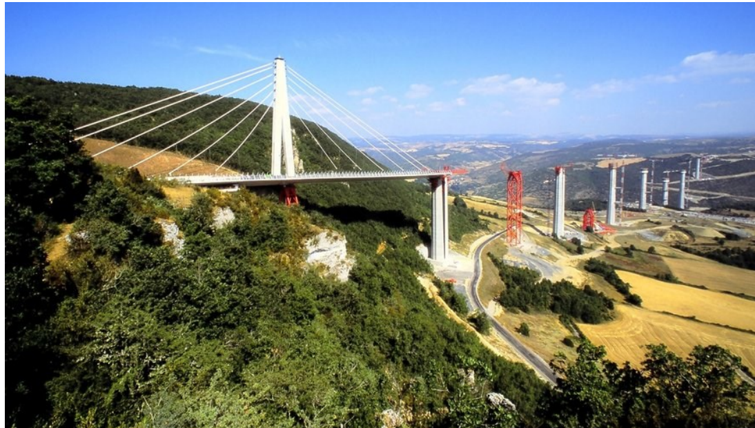
Construction du viaduc de Millau
