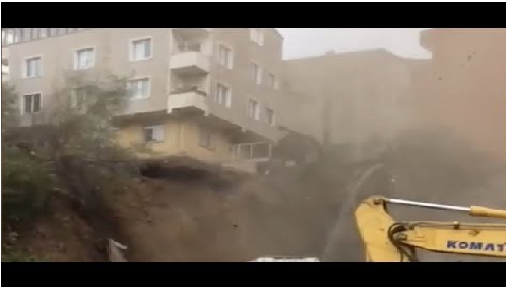
Effondrement d'un écran de soutènement à Istanbul en Turquie suite à des pluies diluviennes
