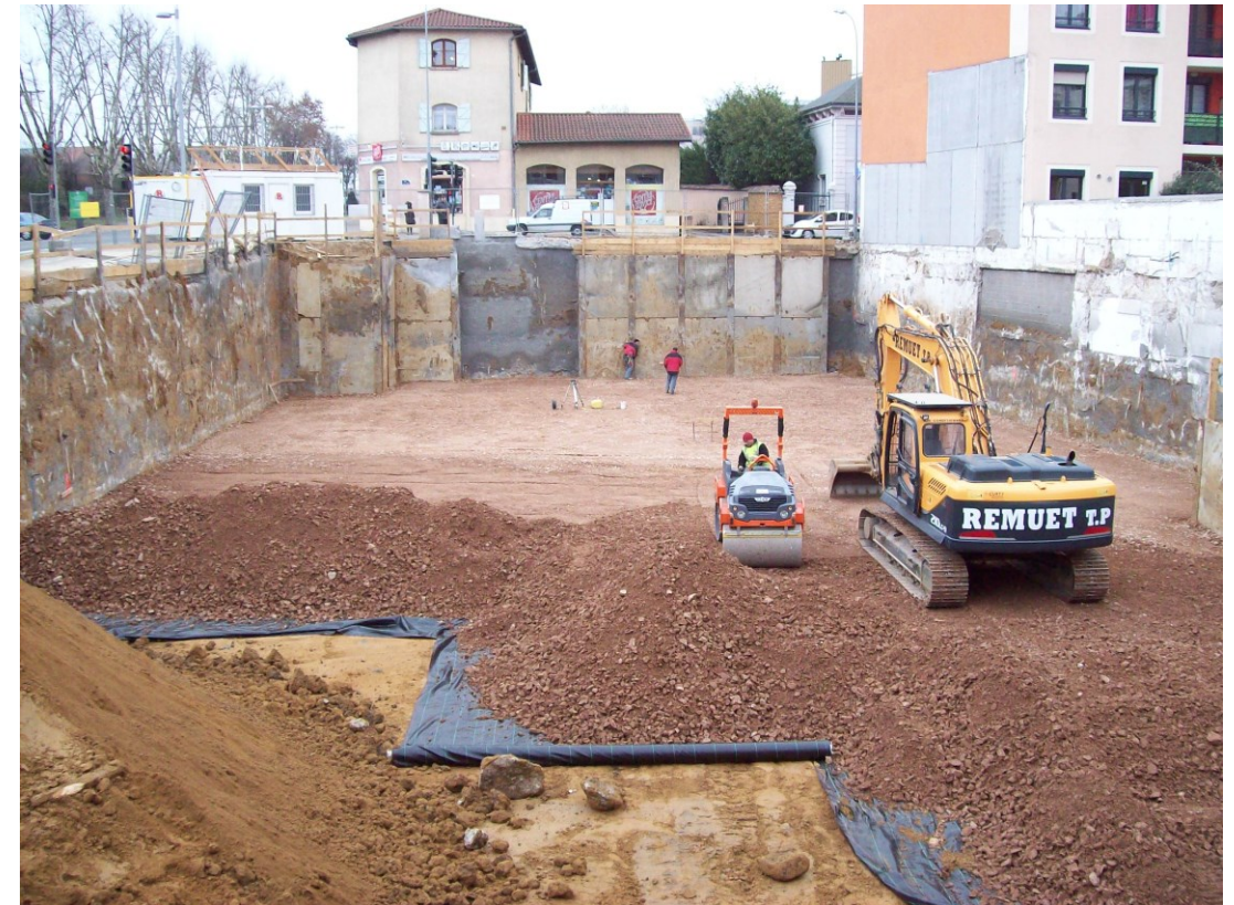
Excavation pour la création d'un sous-sol
