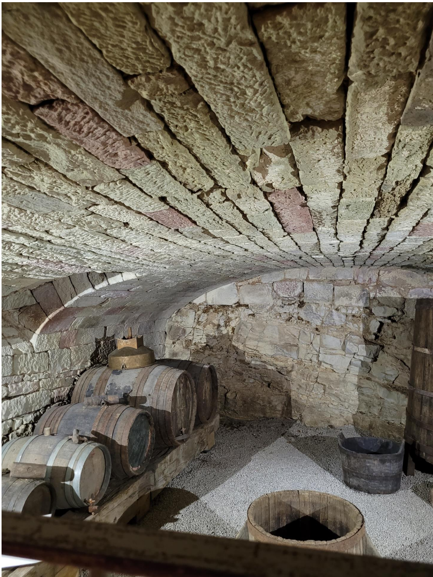
Au sous-sol, la cave voûtée en anse de panier du XV ème -XVI ème siècle
