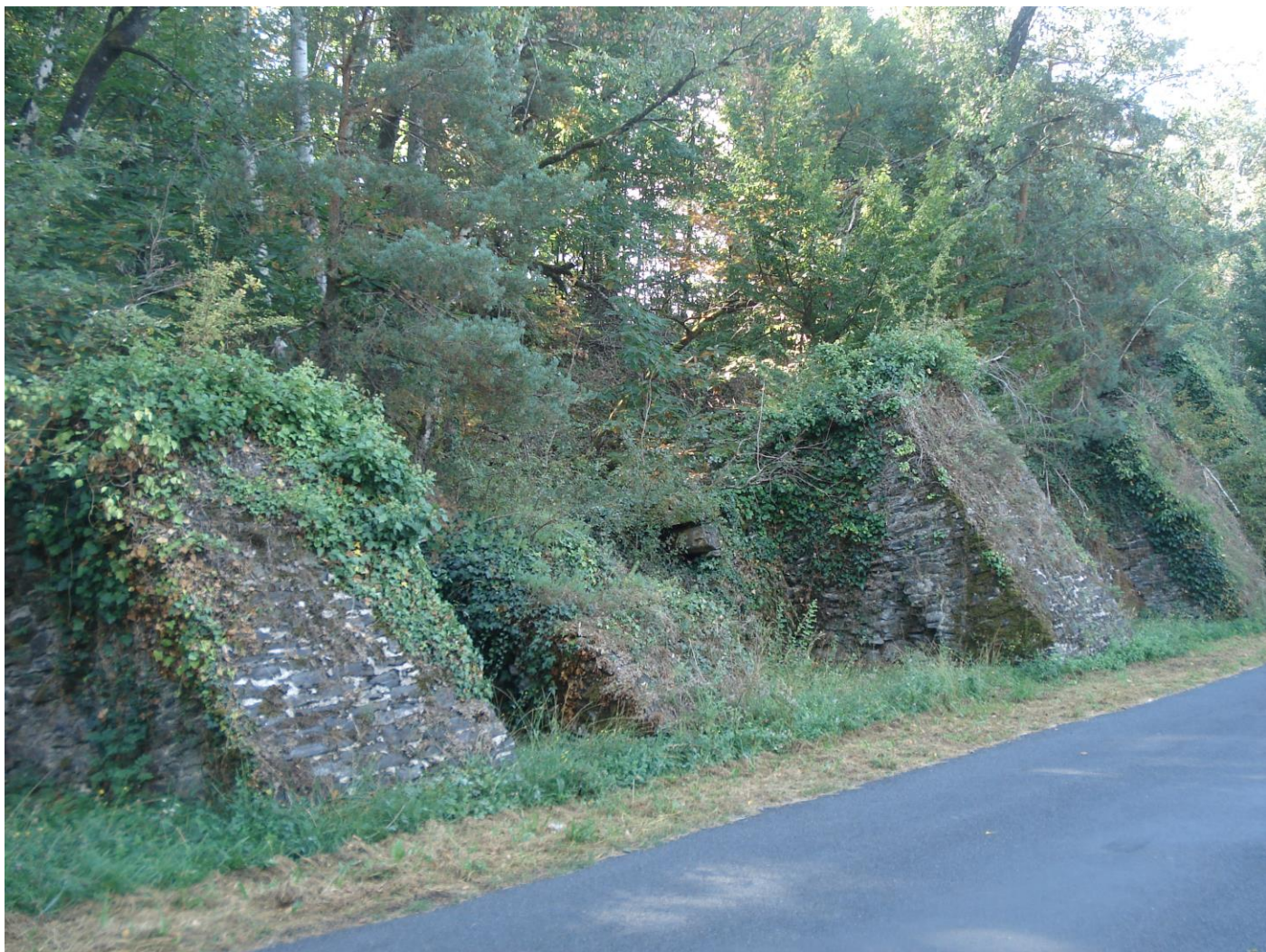
Murs de soutien de la butte ardoisière
