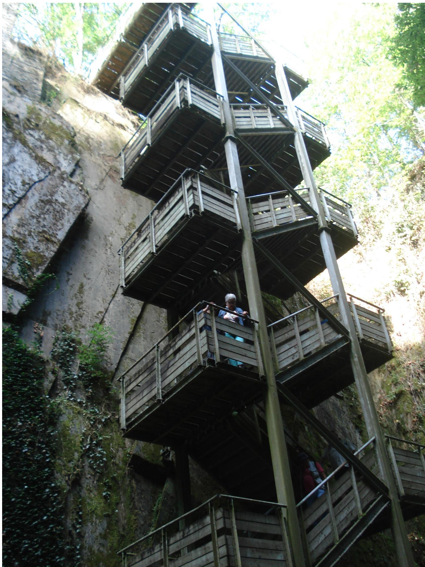
Escalier descendant le long de la paroi d'un « pan » et menant au musée
