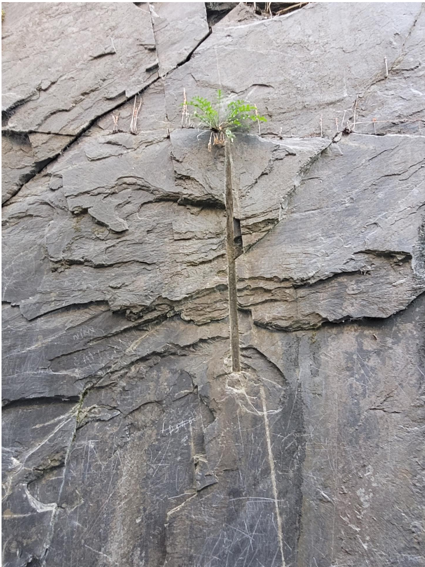
Trous de forage verticaux et horizontaux sur la paroi d'un « pan »
