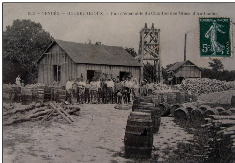
Les alentours du puits Marze avec le minerai (Stibine) et les tonneaux pour le transport de l'oxyde d'antimoine (Collection G. BLANCHARD)
