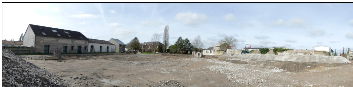
Le site après la démolition de janvier 2023 (Photo D. LOIZEAU)
