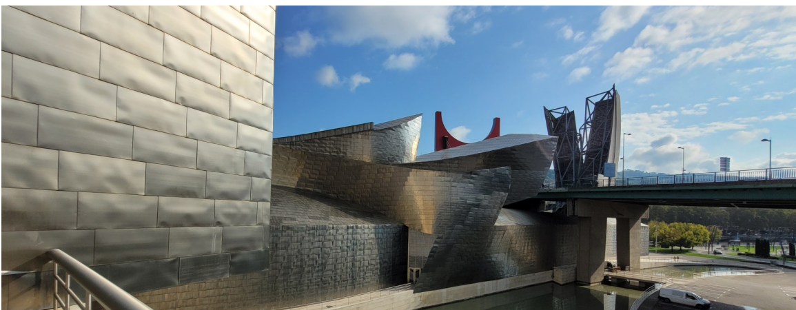
Le bâtiment créé par l'architecte Frank Gehry est recouvert de plaques de titane disposées en écailles
