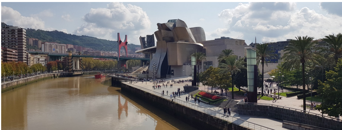
Arcs rouges de Daniel Buren sur le Pont de la Salve qui franchit la rivière Nervión
