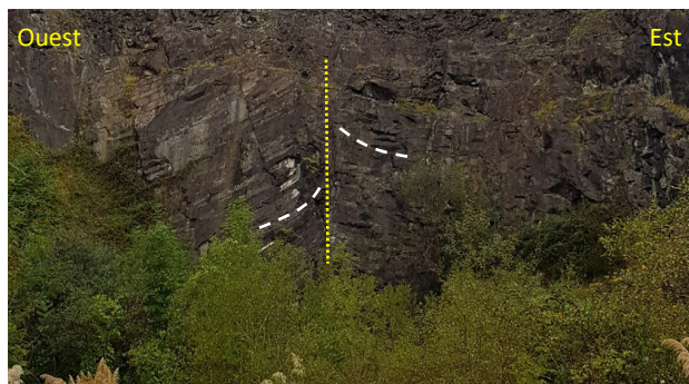
Figure 33 : Partie centrale du front de la carrière De part et d'autre d'une cicatrice verticale médiane, deux piles de prismes légèrement obliques s'affrontent et se redressent quand elles viennent au contact.
