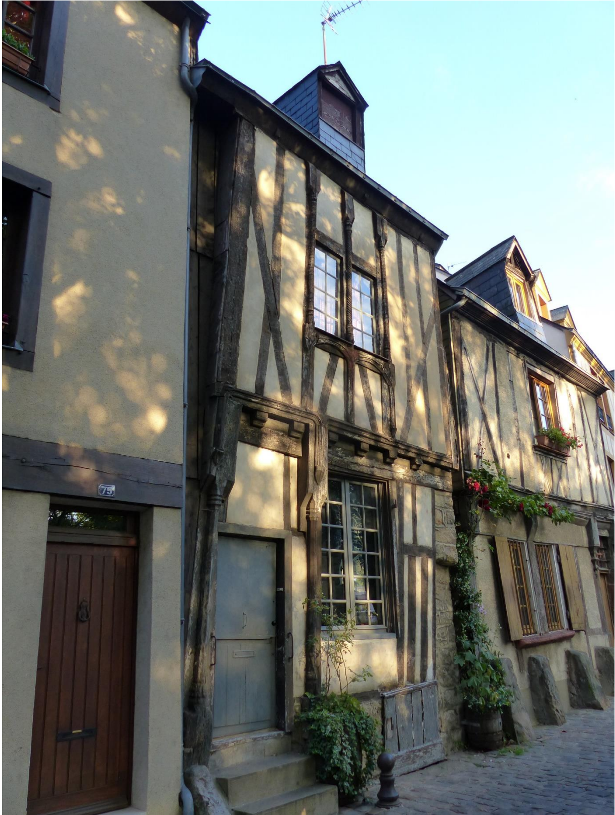
Photo 1 - Rue de la Porte Sainte-Anne (Gothique -1500)
