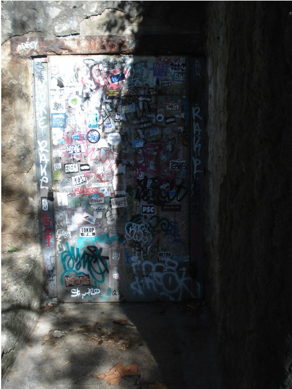
Porte d'entrée dans le tunnel de l'Atalaye (voir arrêt 2)
