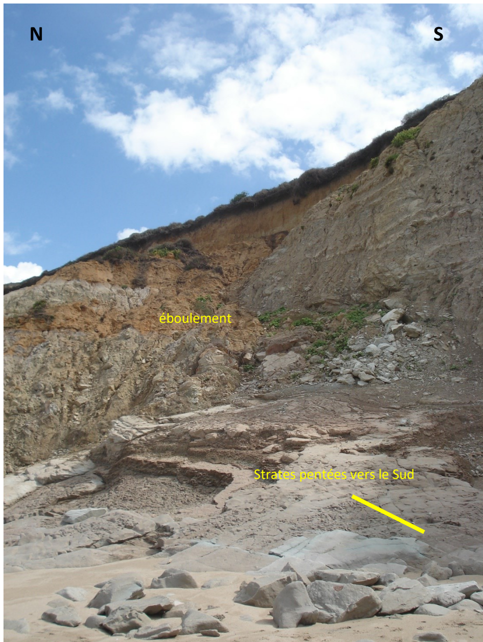
Éboulement : côté Sud
