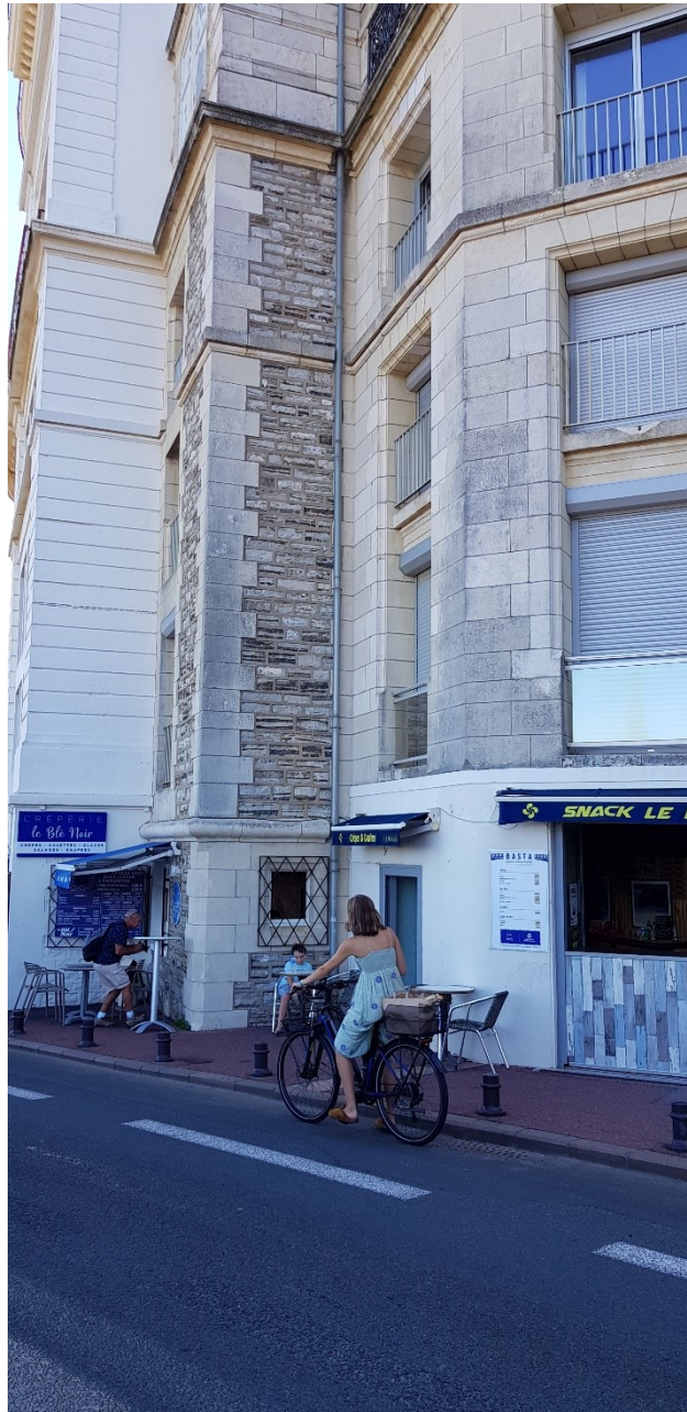
Calcaire à silex dans les angles de l'immeuble
