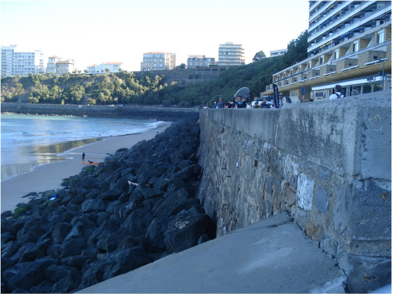
Enrochement constitué de blocs d'ophite
