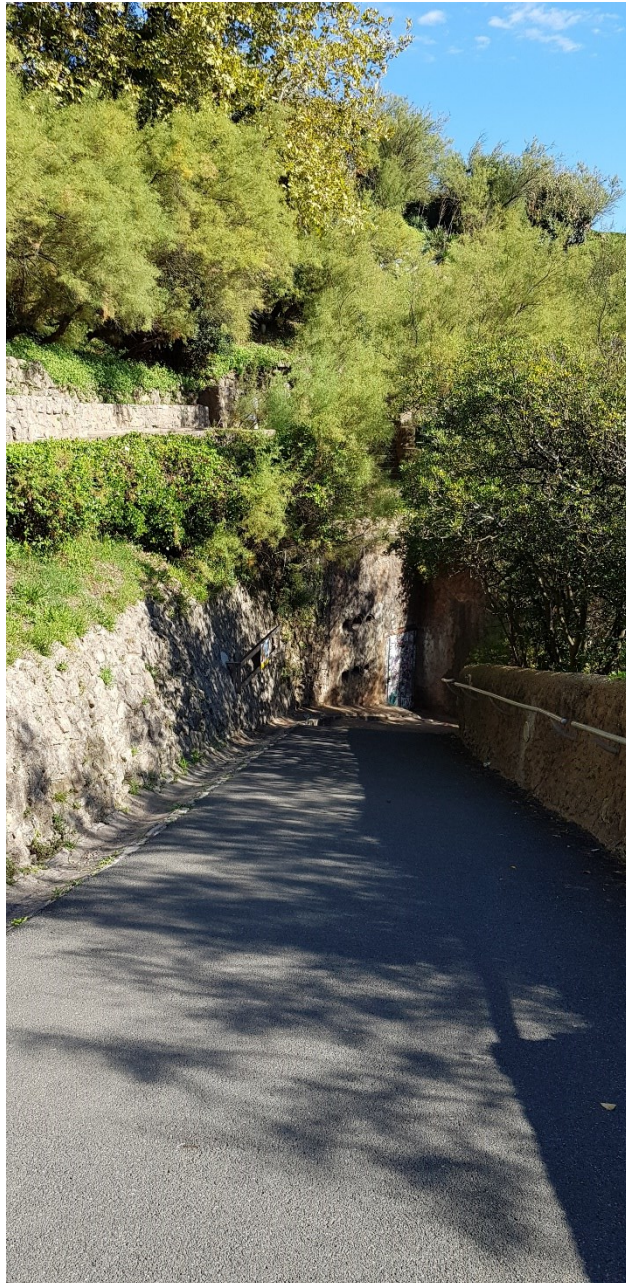
Descente vers la porte d'accès à la « Caverne » de l'Altaye
