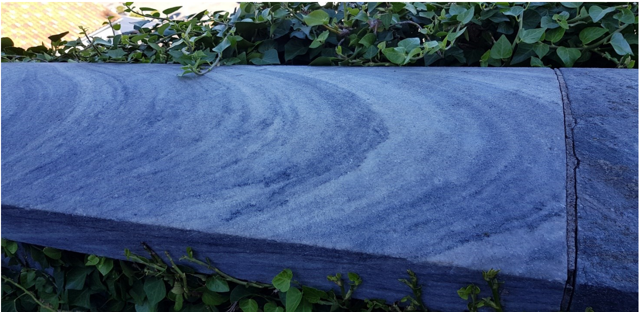
Mur décoré de pierres de parement Ici, ce sont des calcaires métamorphisés en cipolin.
