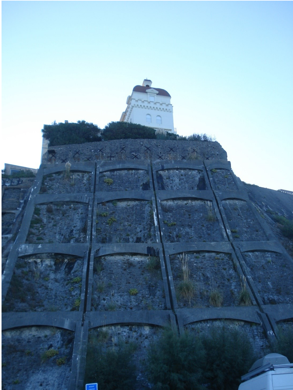
Arcatures en béton sous la Villa Lilinita
