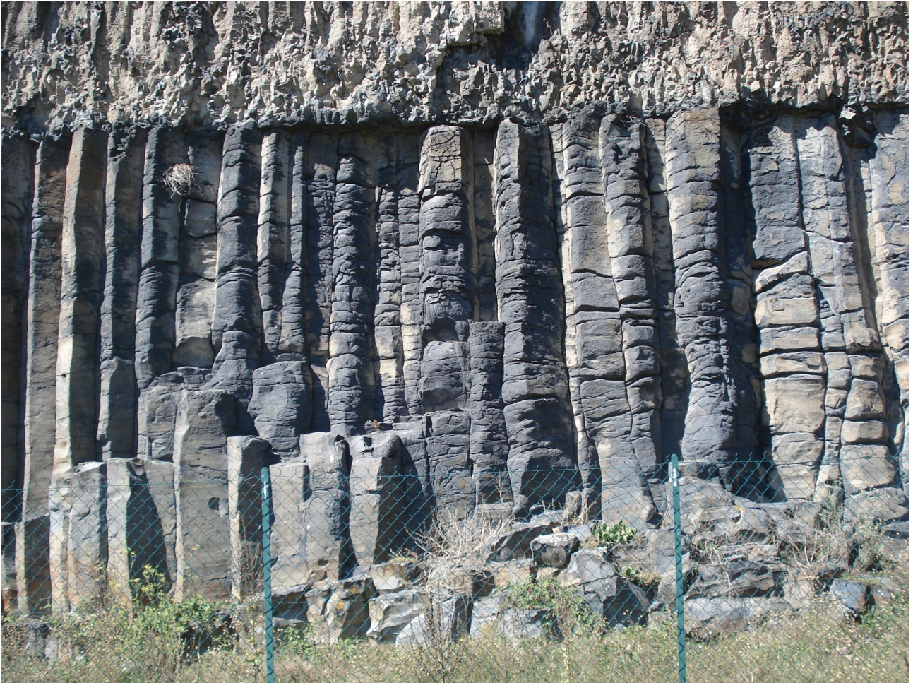
Figure 34 : Orgues basaltiques de Chillac (Haute-Loire)
