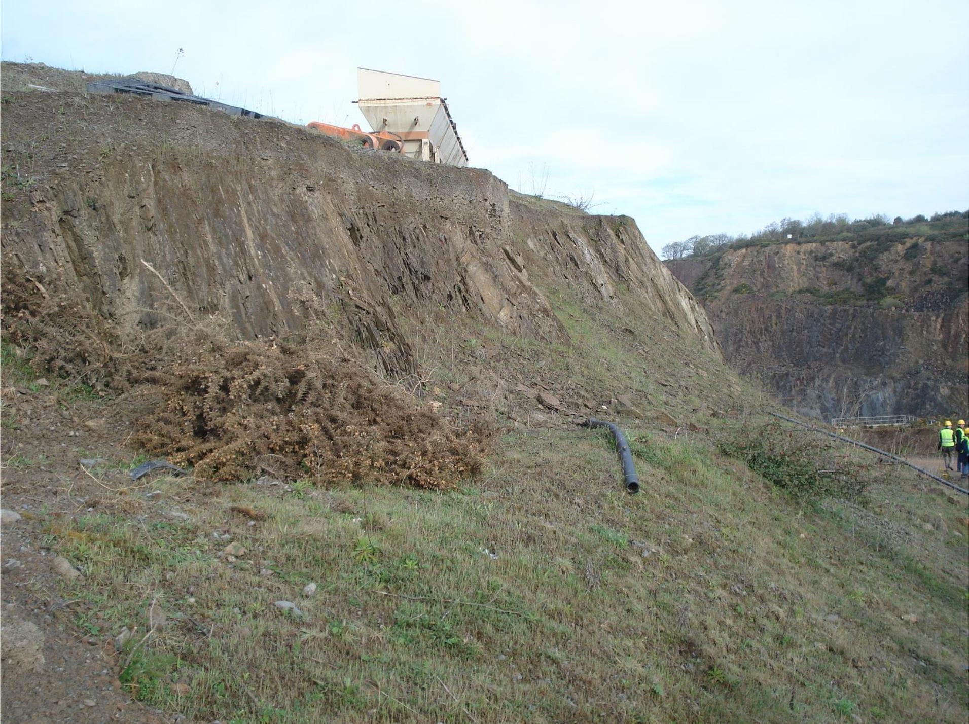
Cannelures et traces d'arrachement en « ressauts » dans les plans de schistosité de la méta-argilite ordovicienne
