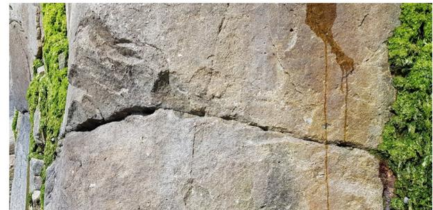
Traces des « avant-trous » faits au poinçon et à la massette
