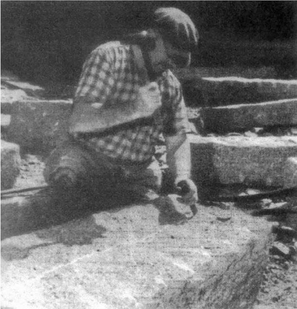
**Traçage au poinçon et à la massette
