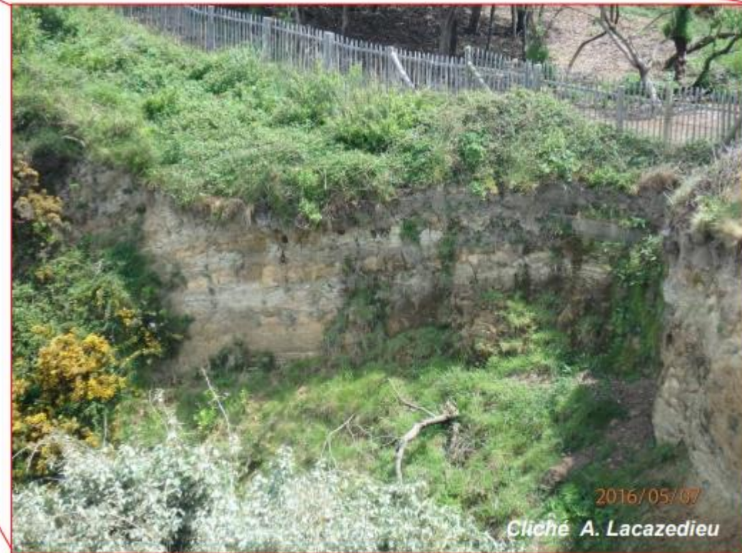
Vue de détail des altérites
