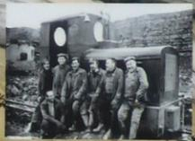
Extrait à l'aide de pelleuses ou à la main, le calcaire était chargé dans des wagonnets tirés par des chevaux ou des mules. Puis, on venait atteler ces wagonnets au train privé pour approvisionner les fours de l'usine du Ham. Le ciment est obtenu en portant à 1450°C un mélange de calcaire et d'argile. De l'argile issue de la couche préliminaire de la carrière était donc aussi acheminée.
