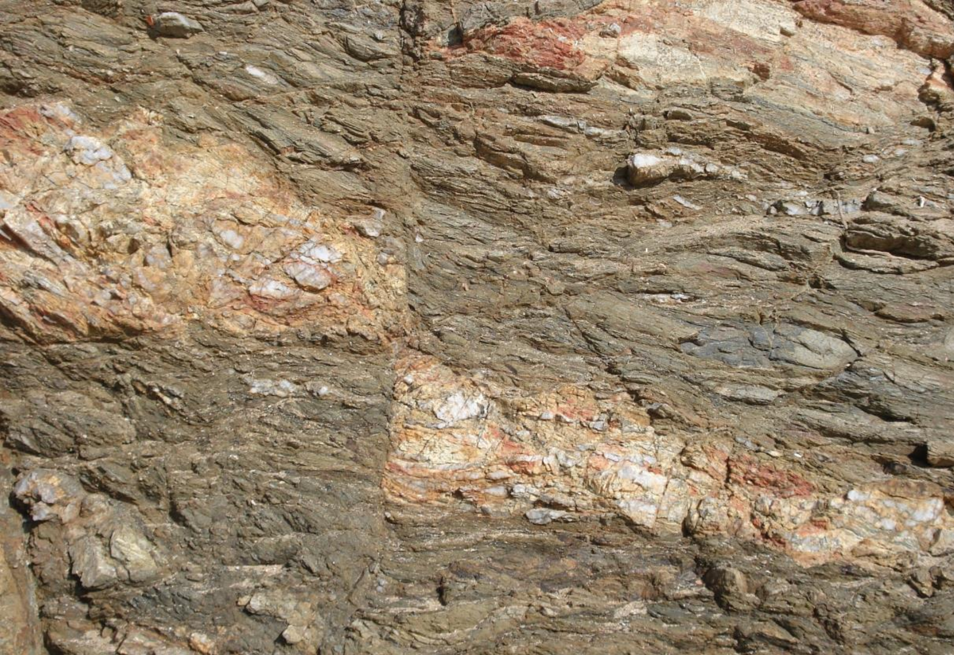
Faille dans un banc de tuffites – Sauveterre (85)
