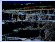
Front de taille de la carrière Cemex à Ségrie
