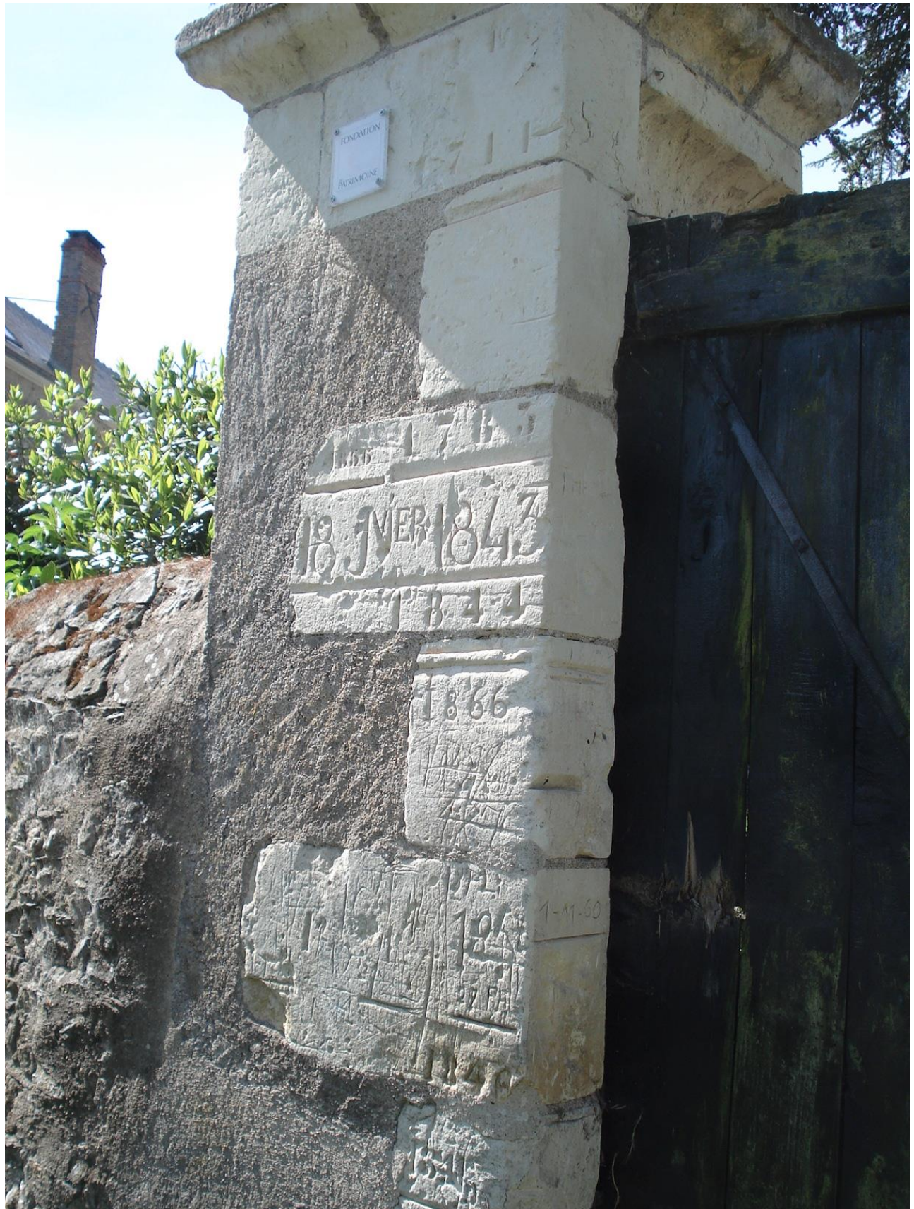
Pilier droit du Portail avec échelle des crues
