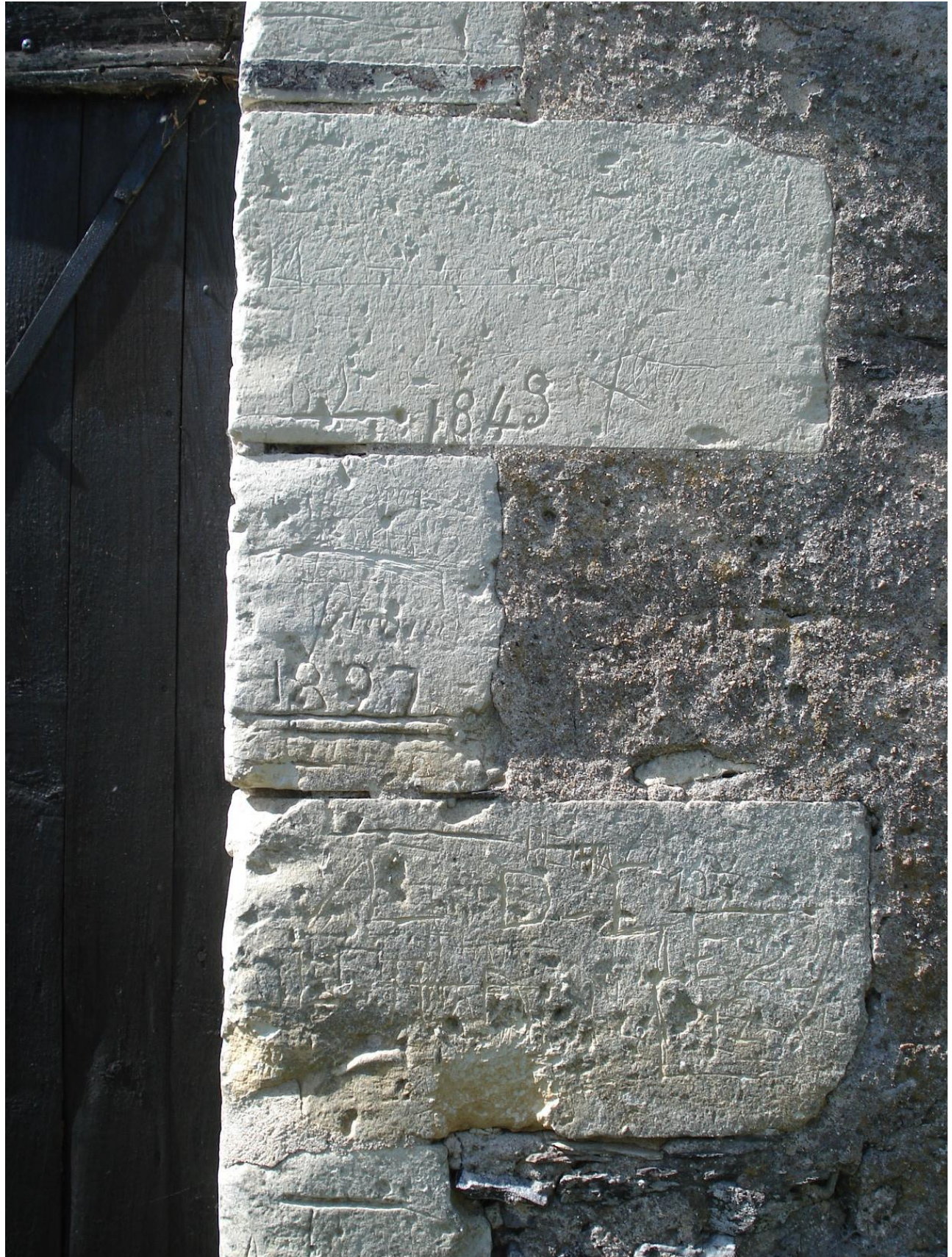
Pilier gauche du Portail en tuffeau avec échelle des crues
