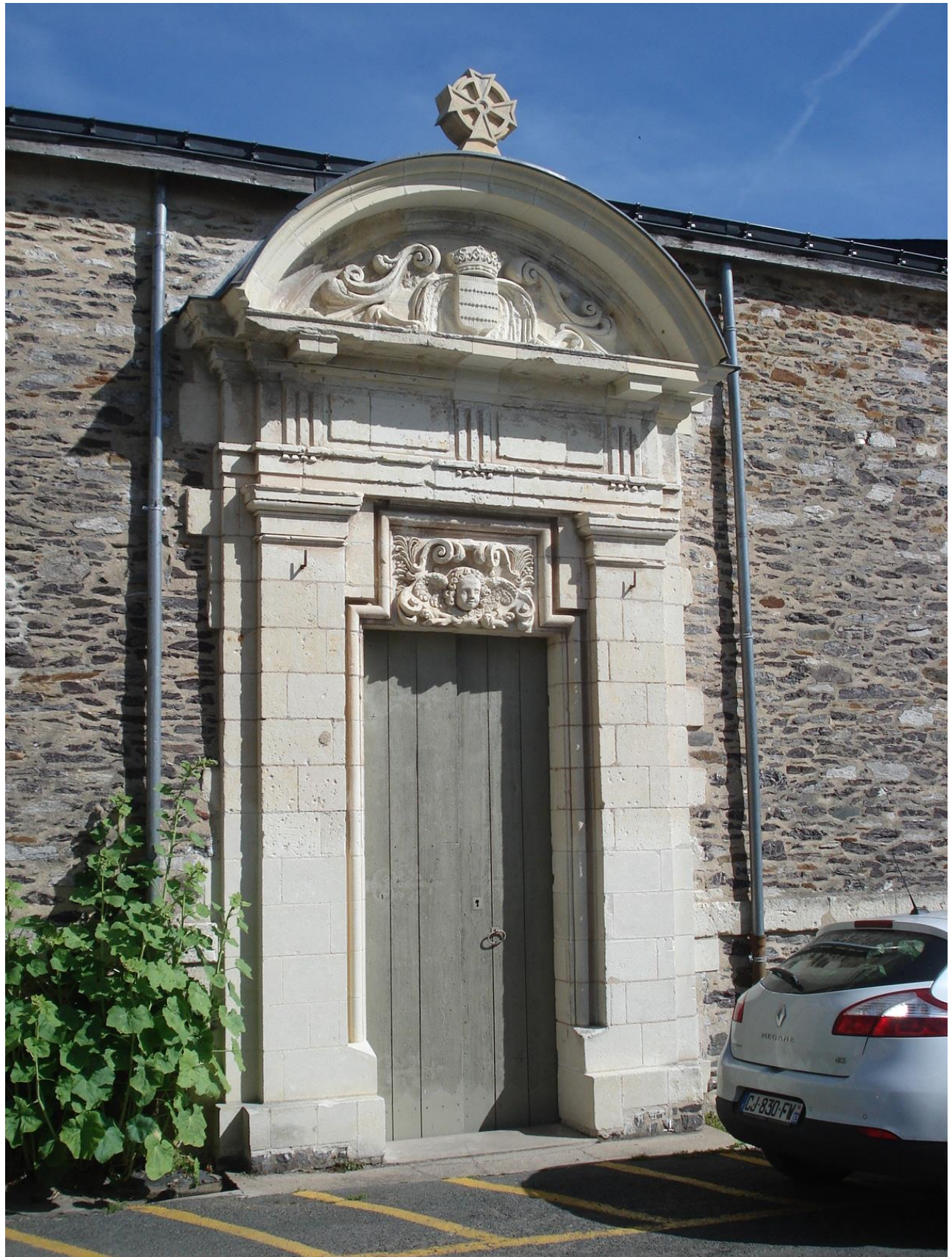
Portail restauré en tuffeau
