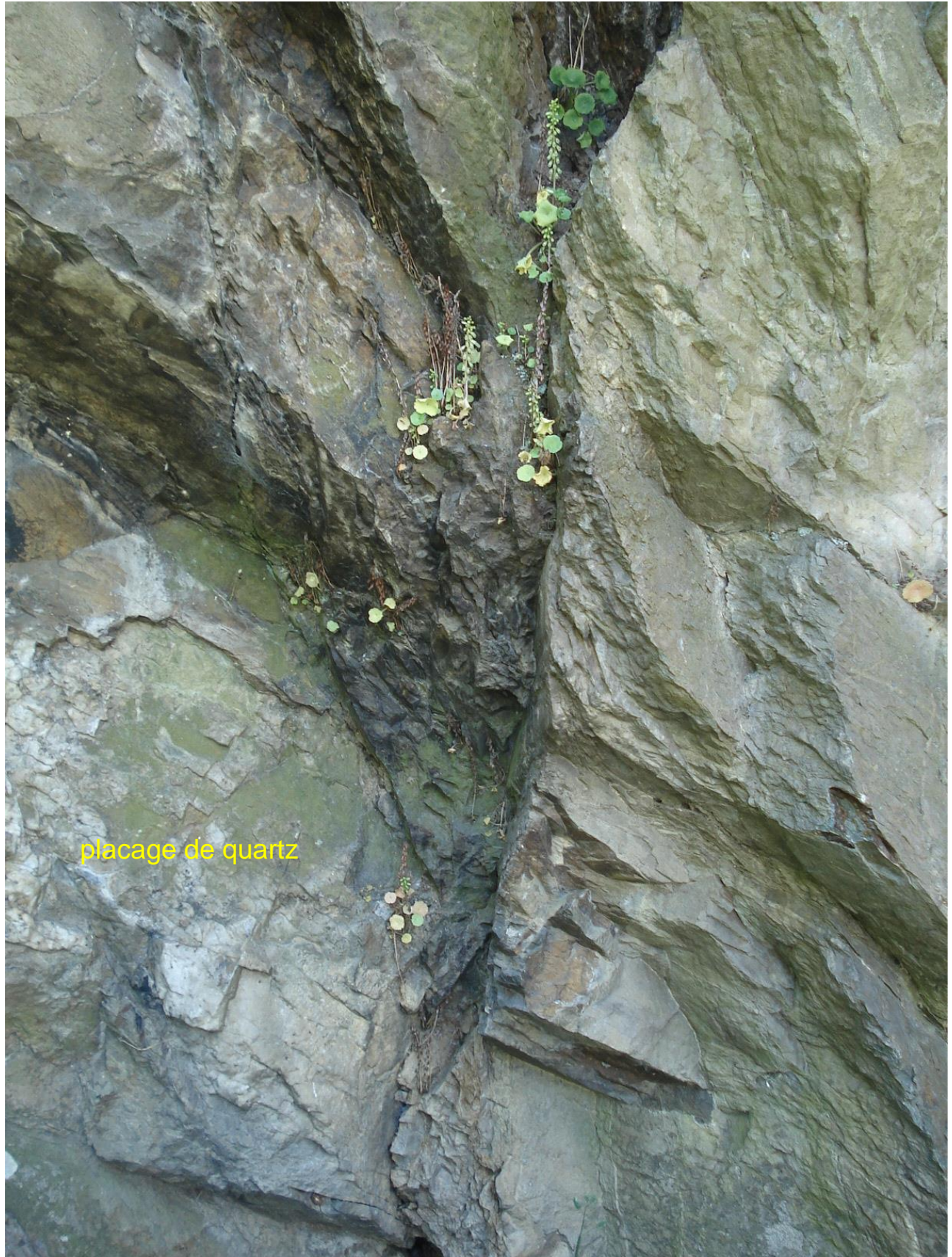
Placage de quartz dans les plans de fracture
