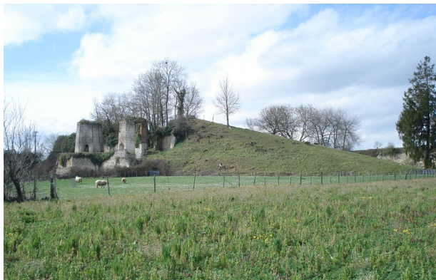
Vue d'ensemble des fours à chaux avec leur rampe d'alimentation
