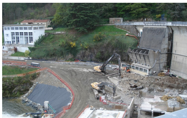
Le barrage de Mervent en travaux
