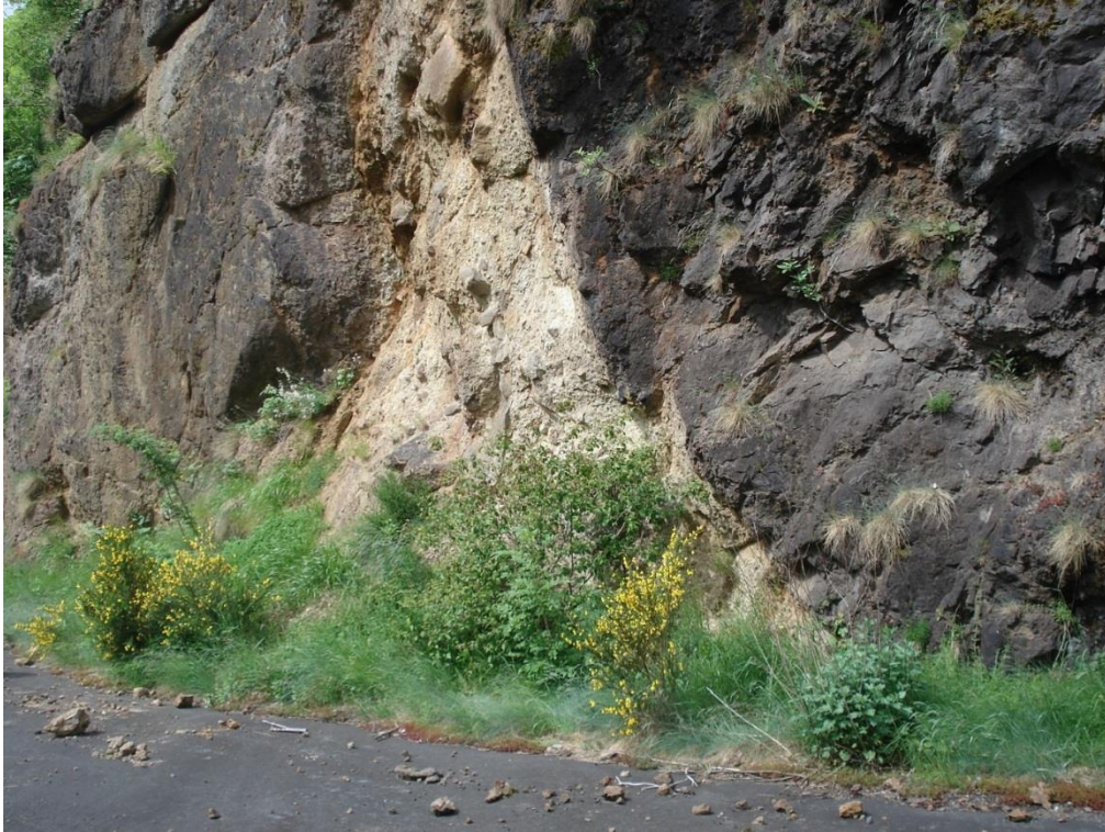
Deux mégablocs de basalte séparés par une matrice claire
