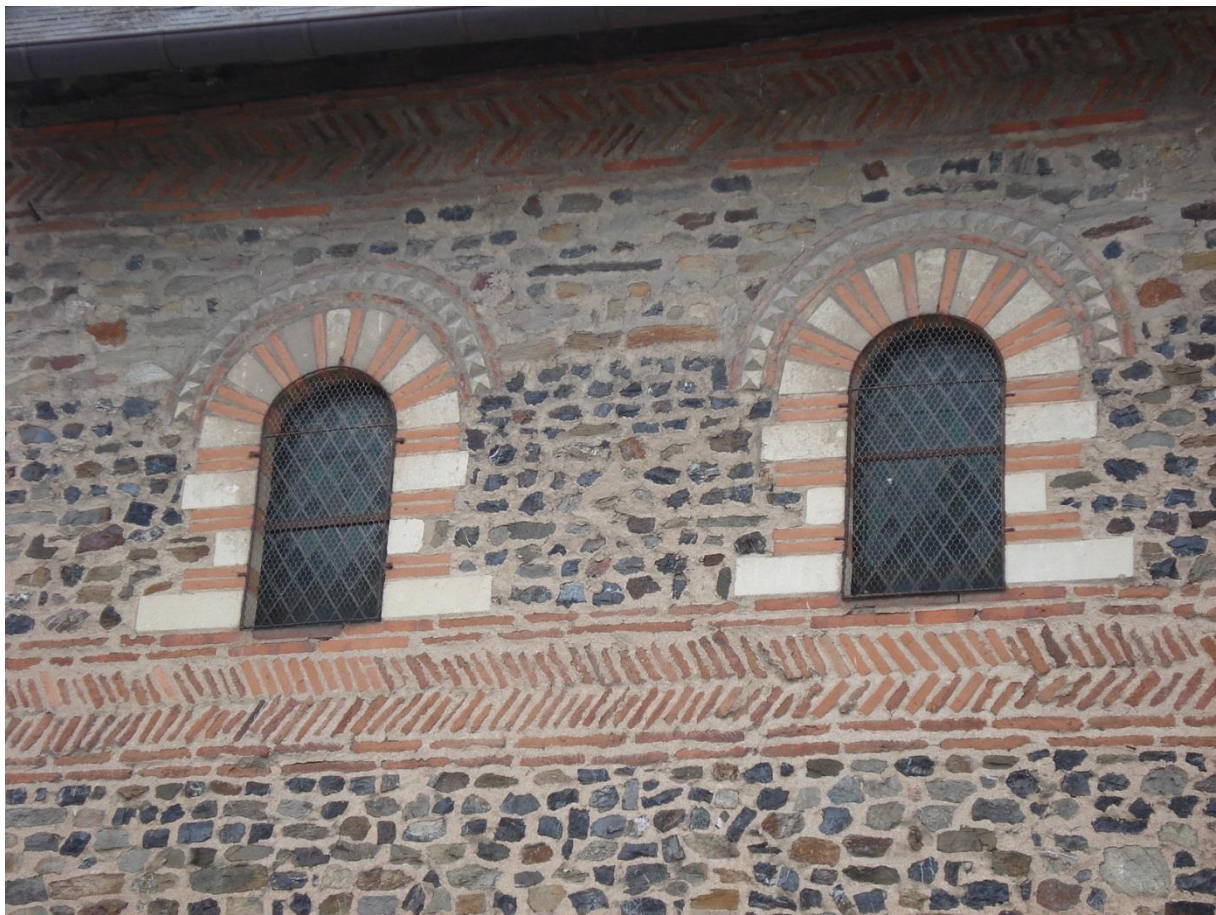
Baies de style roman surmontées de pointes-de-diamant
