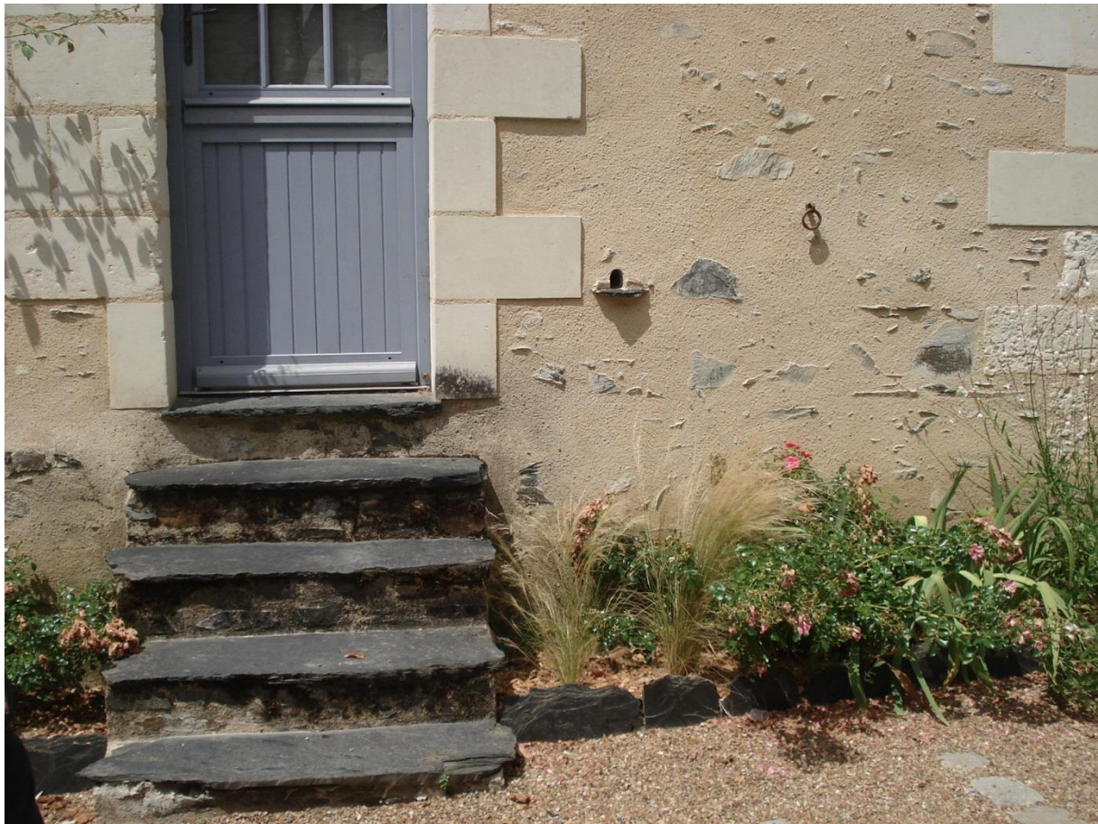
Marches en ardoise pour accéder à la maison, preuve que le sol de cette dernière a été surélevé
