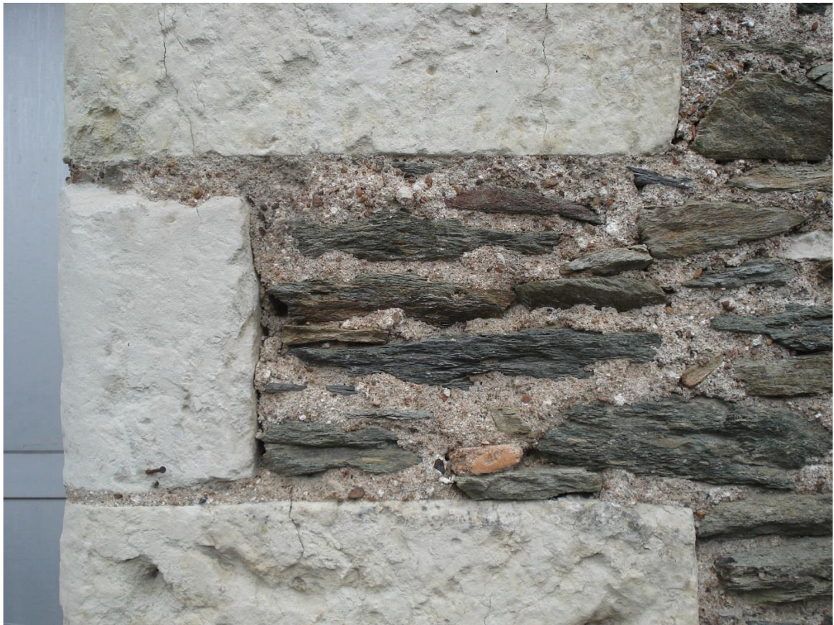
Mur en schiste et pierres d'angle en tuffeau très altérable
