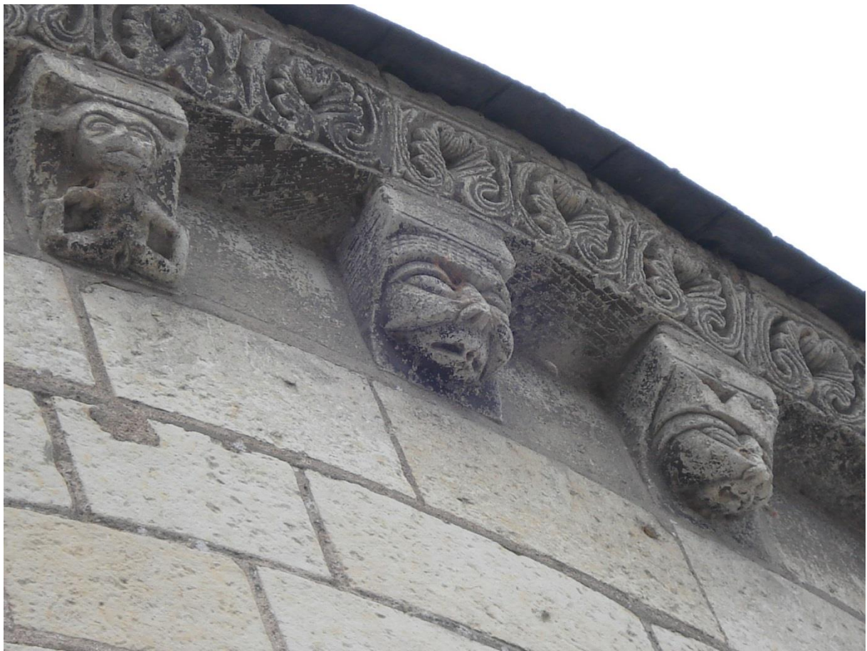
Corniche du chevet avec sa frise et ses modillons
