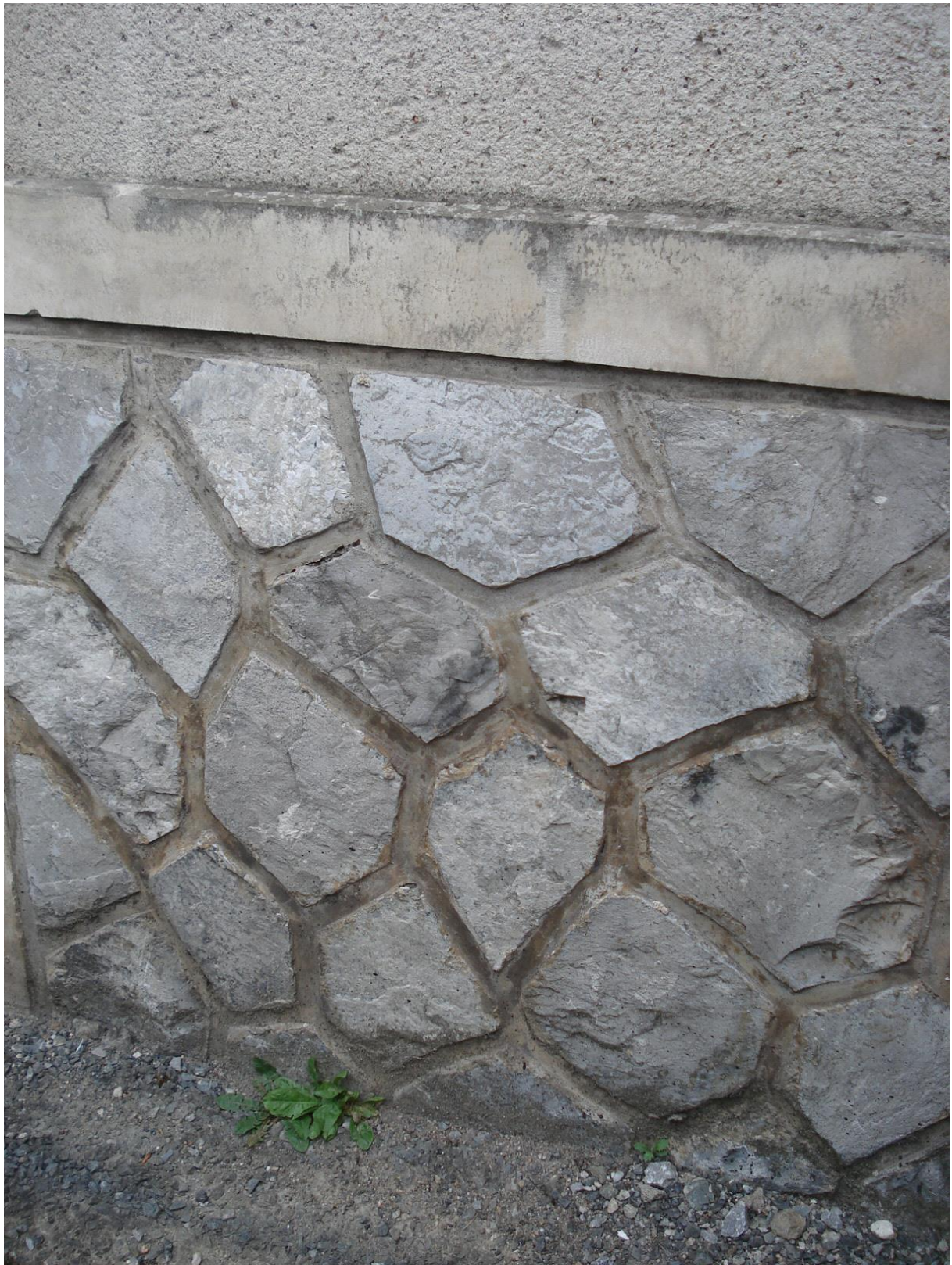
A la base des murs, calcaire dévonien à coraux en opus incertum
