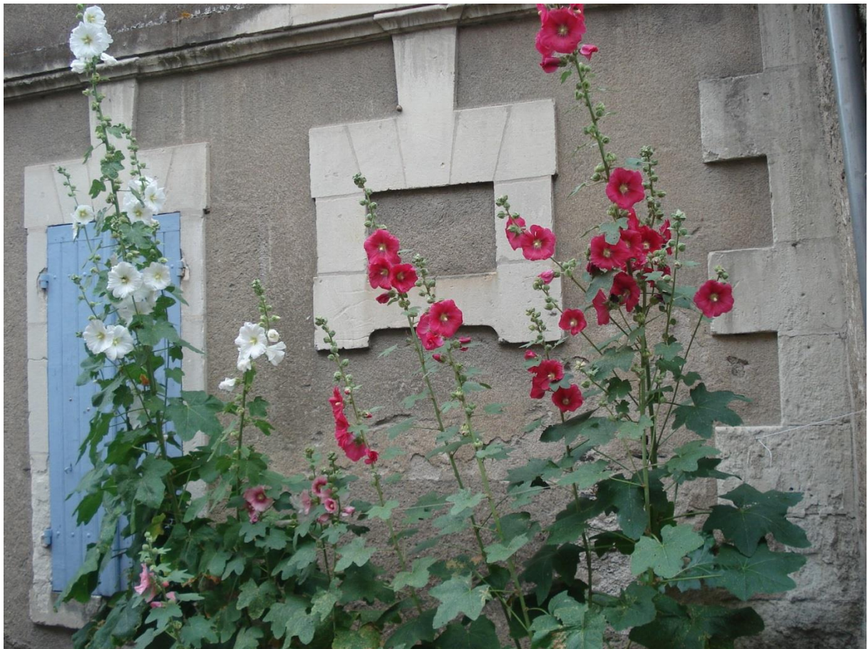
Parement de fenêtre (en haut) et parement d'angle (en bas) en tuffeau
