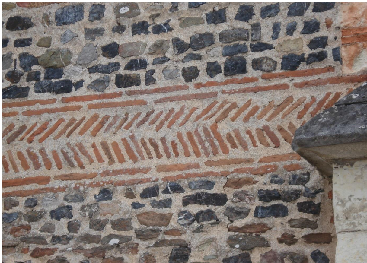
Ceinturon de briques disposées en opus spicatum (ou en « épi » ou en « arête de poisson ») encadré par deux petits cordons de deux rangs de briques posées à plat
