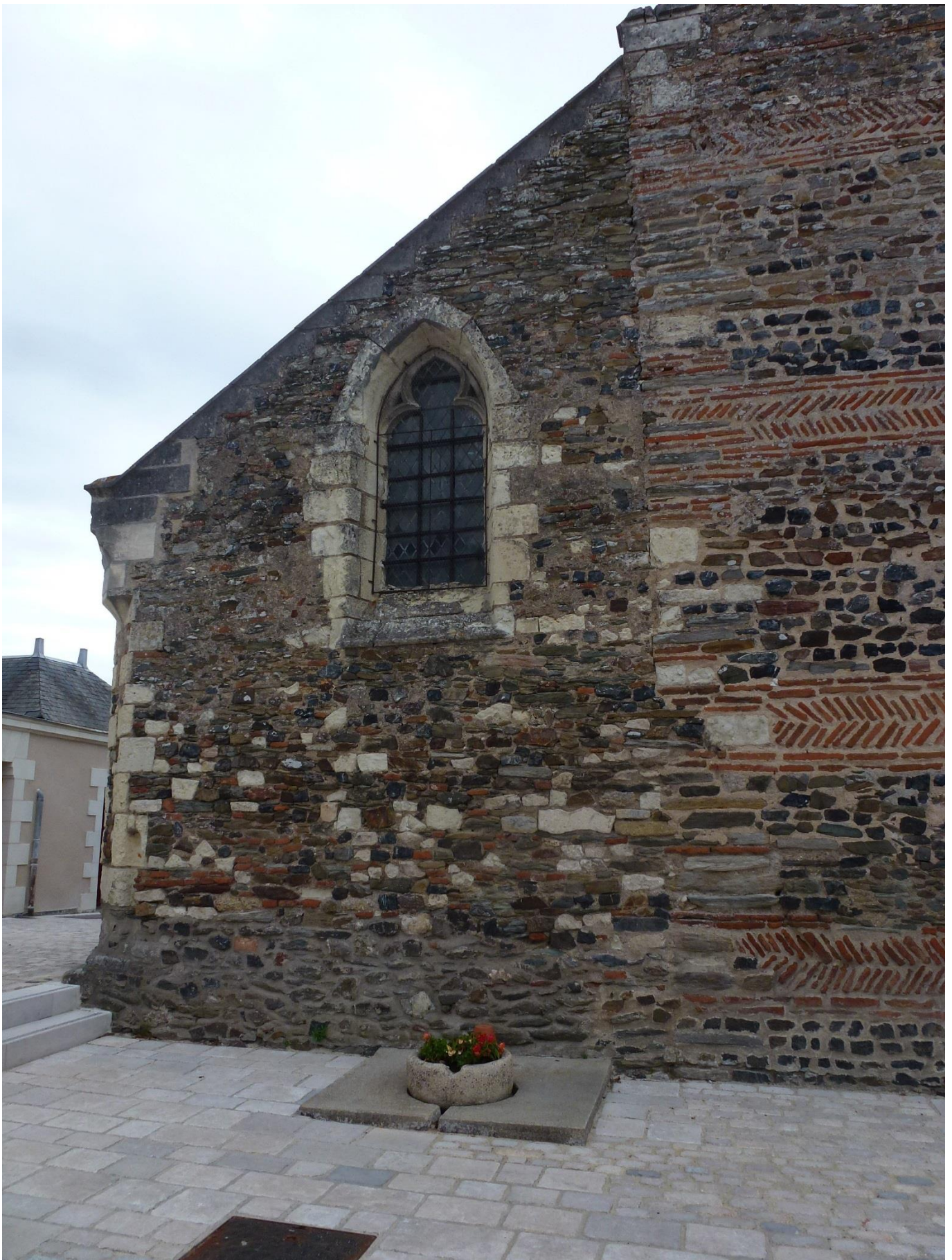
Rajout sur le côté Nord de la façade Ouest
