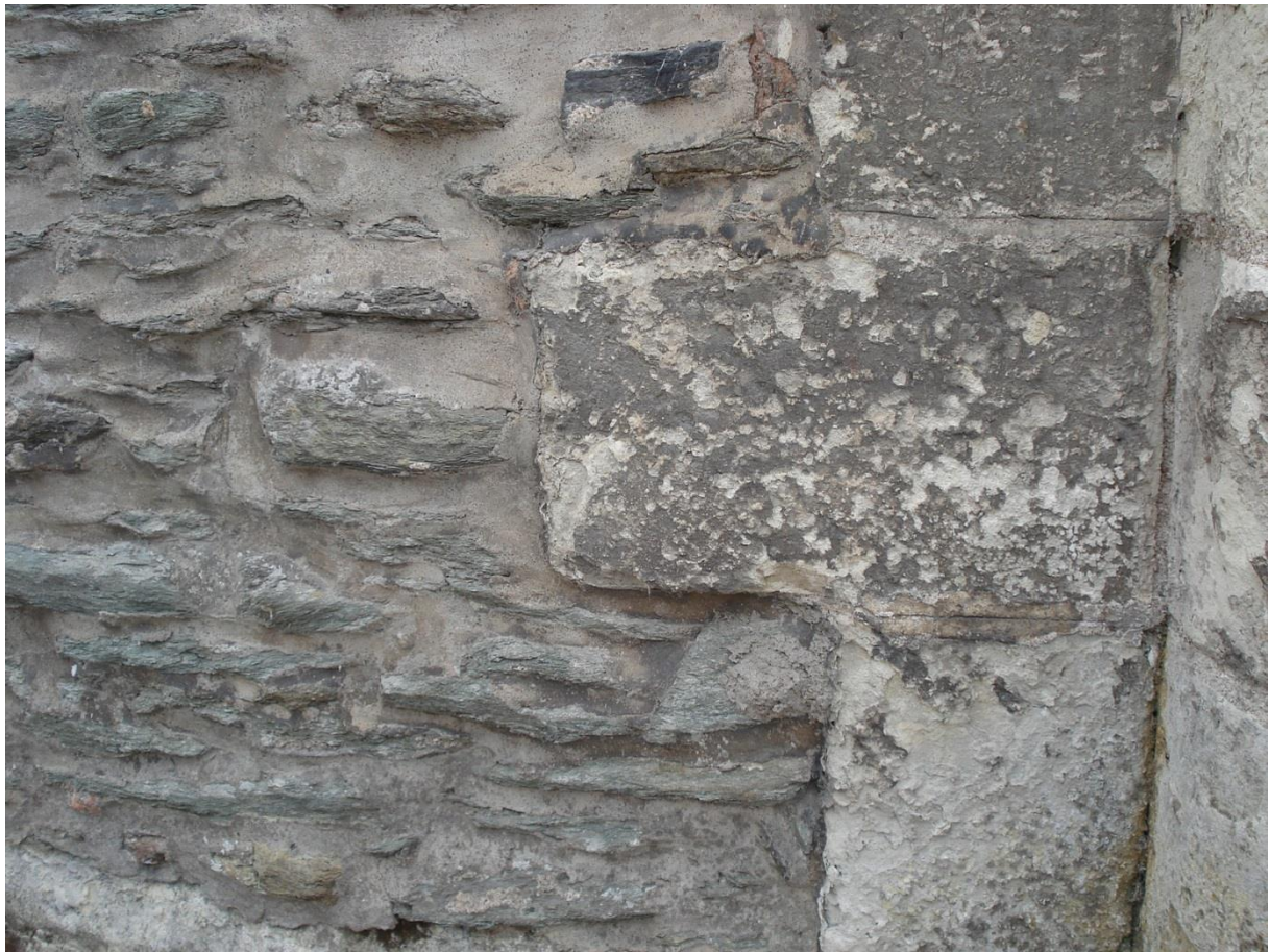
Schistes et pierres d'angle en tuffeau
