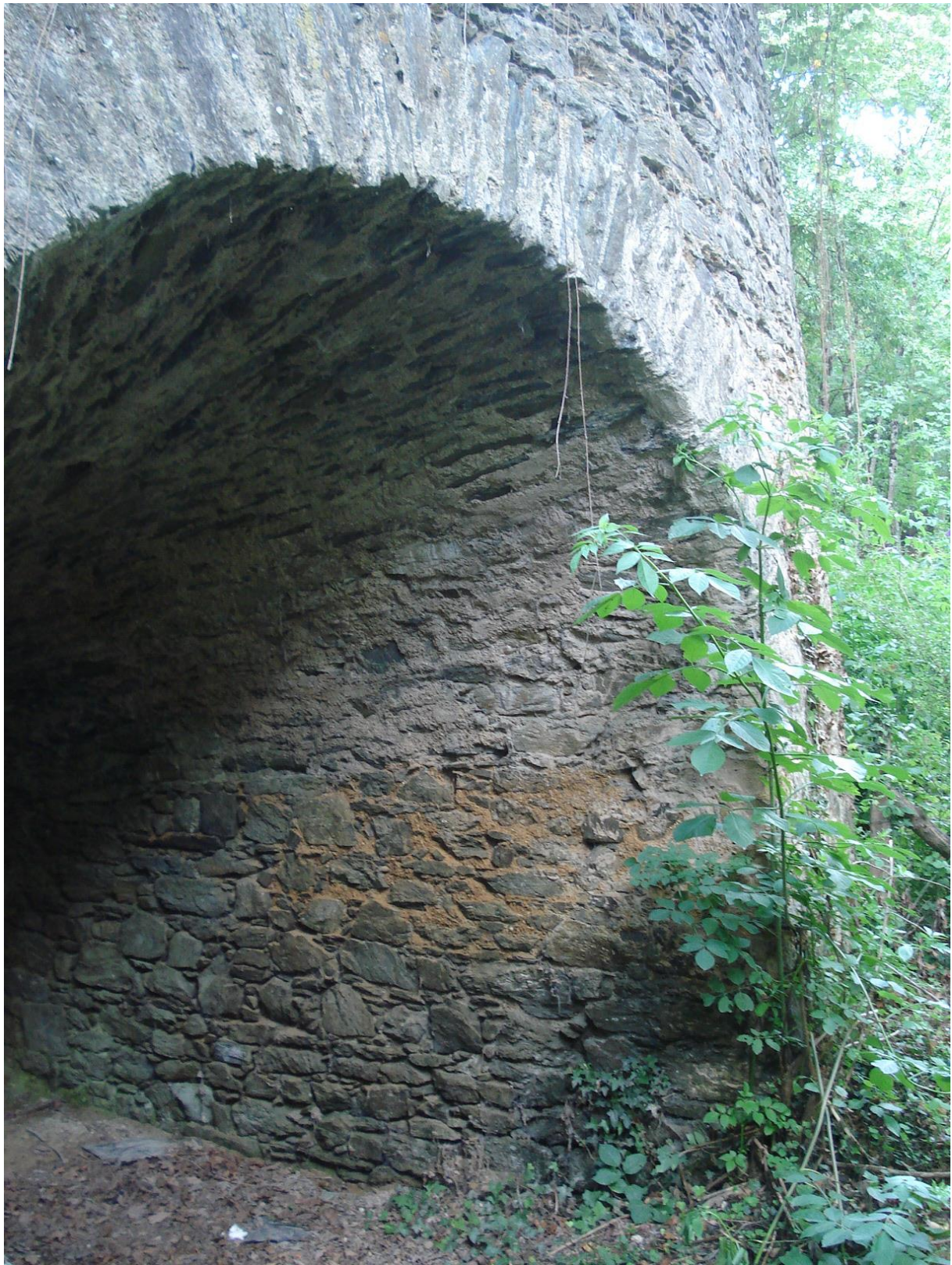
Ébraisoir du four à chaux de Servières
