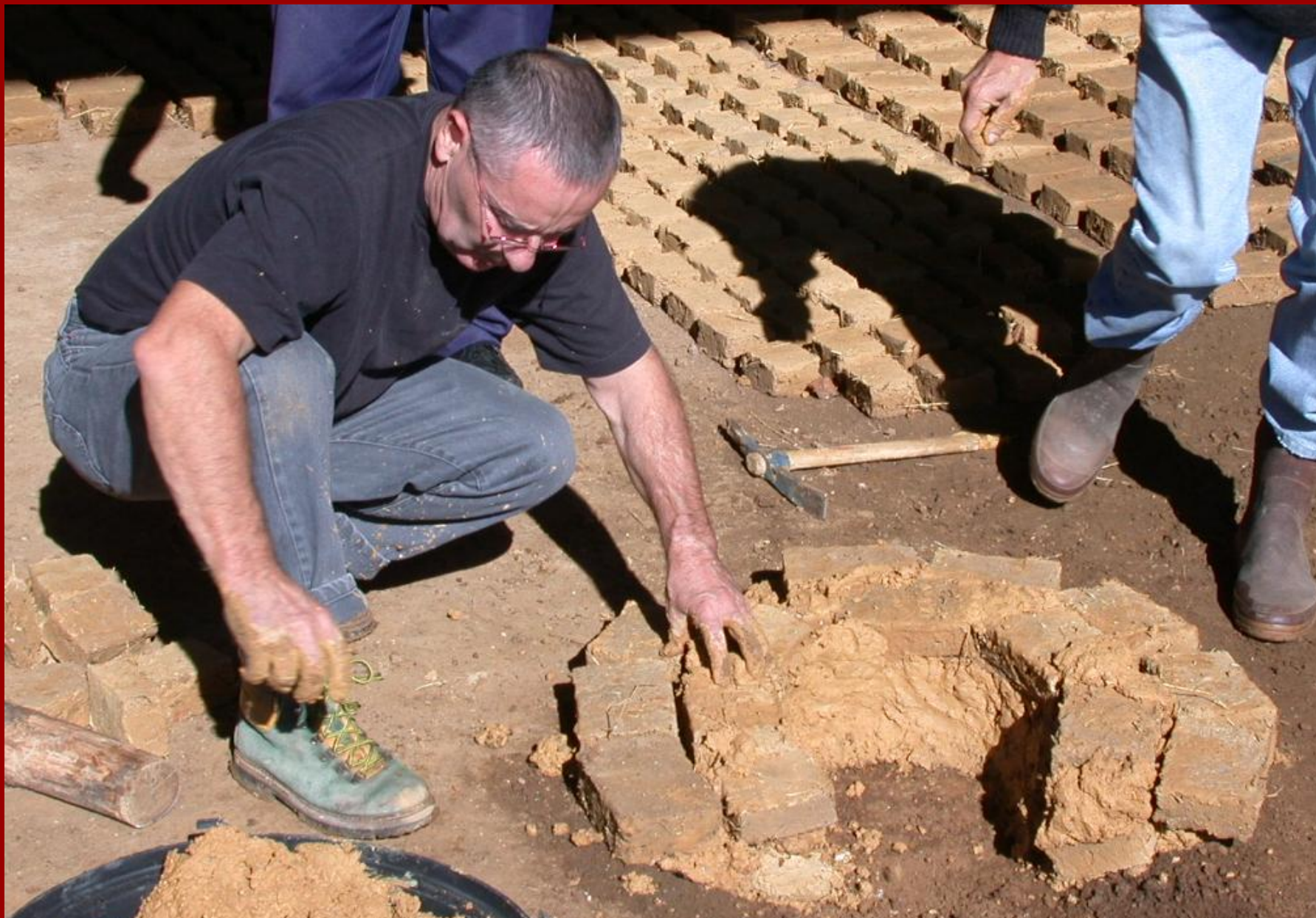
Pose d'une deuxième rangée de briques
