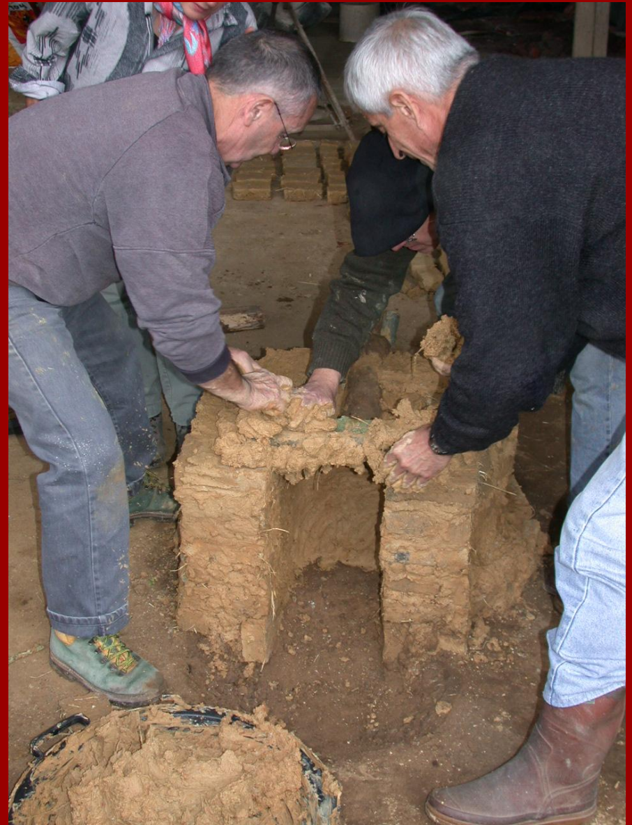
Pose d'un linteau formé de 2 bouts de bois vert enveloppés d'argile
