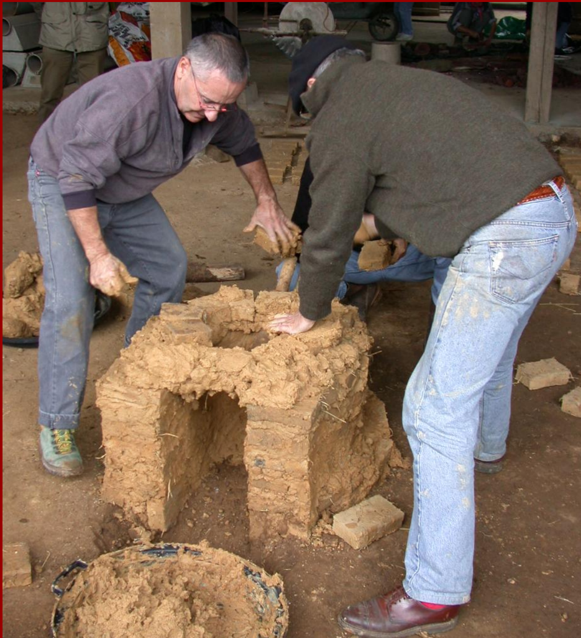
Les maîtres d'œuvre façonnent la base de la cheminée
