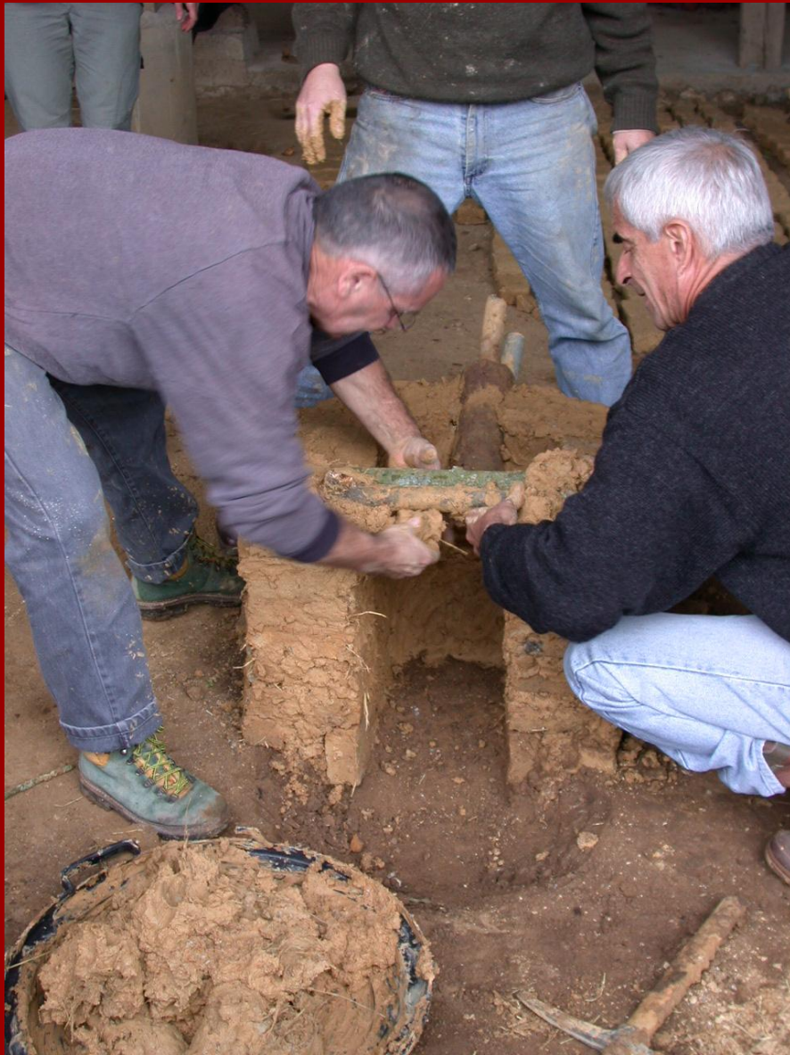
Pose d'un linteau formé de 2 bouts de bois vert enveloppés d'argile
