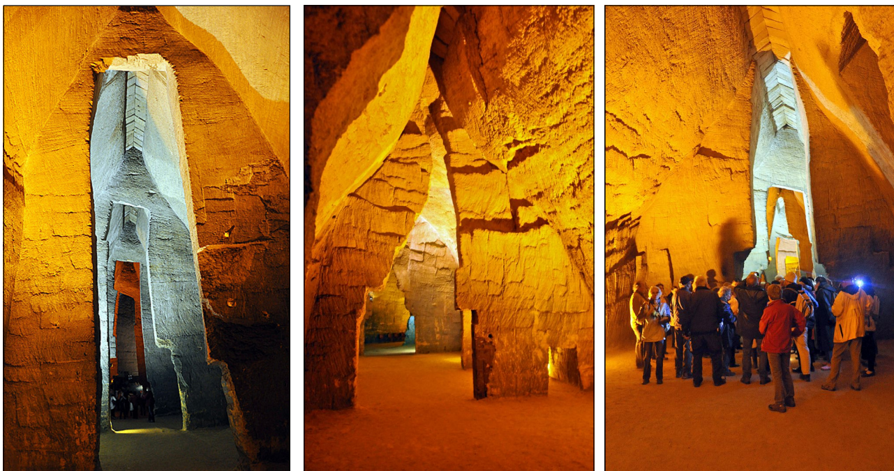
26. Salles souterraines, hautes de 15 à 20 m, avec une voûte ogivale, à l'allure de cathédrales magnifiées par l'éclairage
