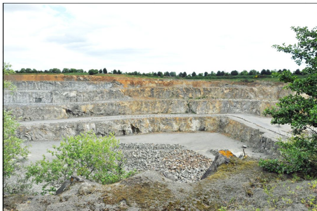
Fig. Carrière de la Gerbaudière vue de la plateforme, face à l'entrée
