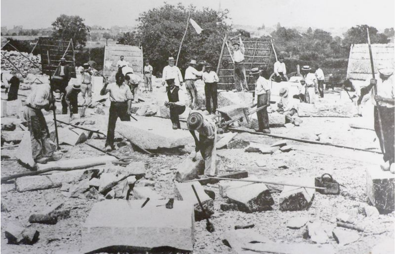
3. BÉCON (M.-et-L.) - Un Chantier des Carrières de Granit - A. B.
